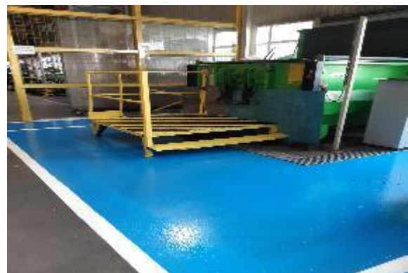
Zona compactare deseuri carton Logistica Presaj
