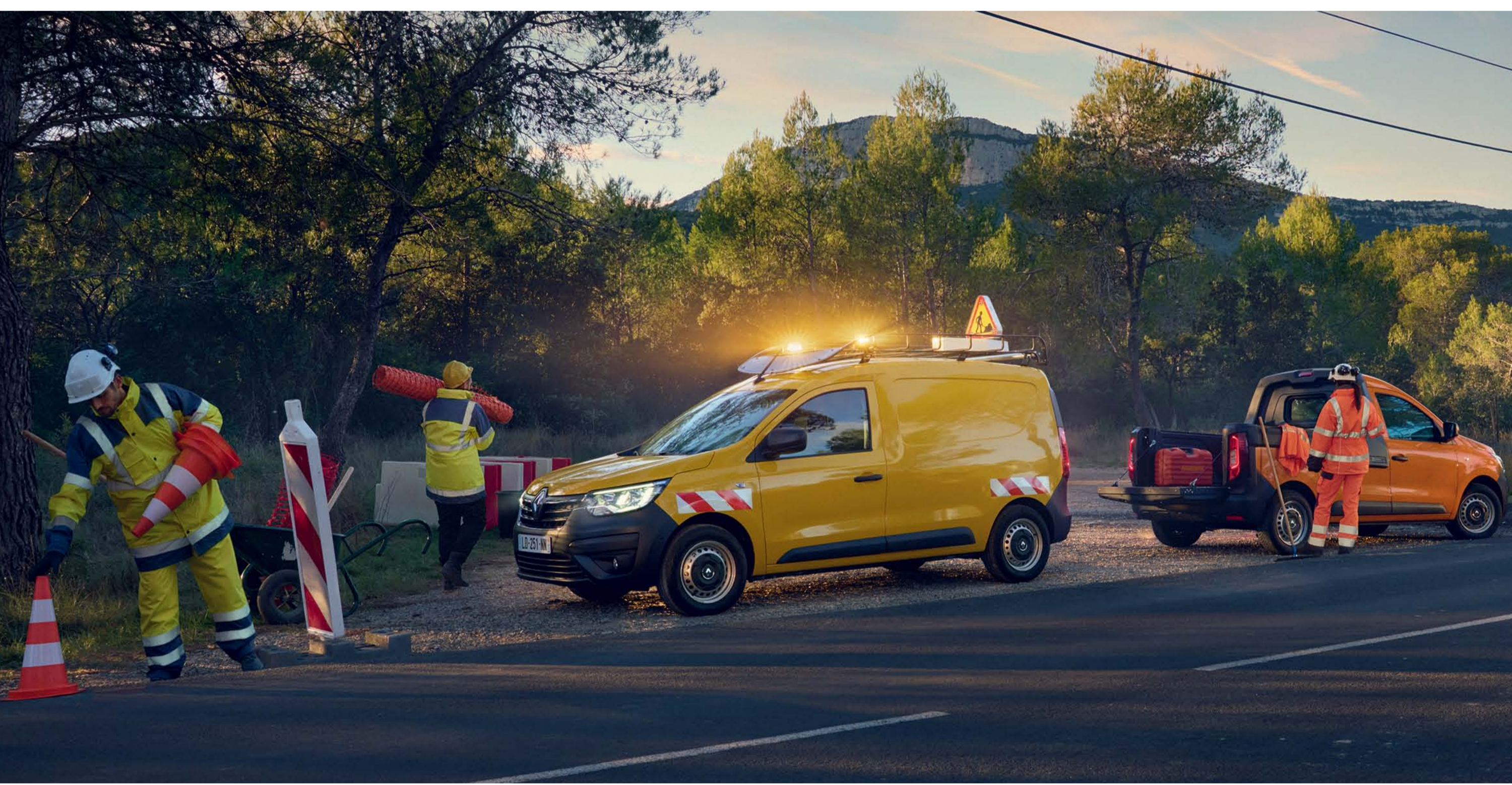
Renault Express Van chantier et pick-up
